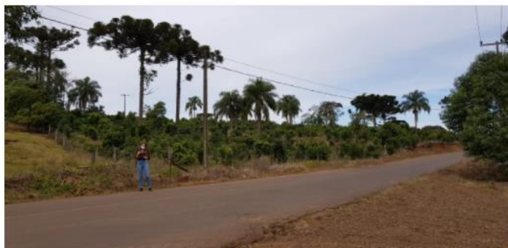
Recapeamento asfáltico e sinalização viária serão realizados na Av. Irineu Bornhausen. Foto: Amaí
